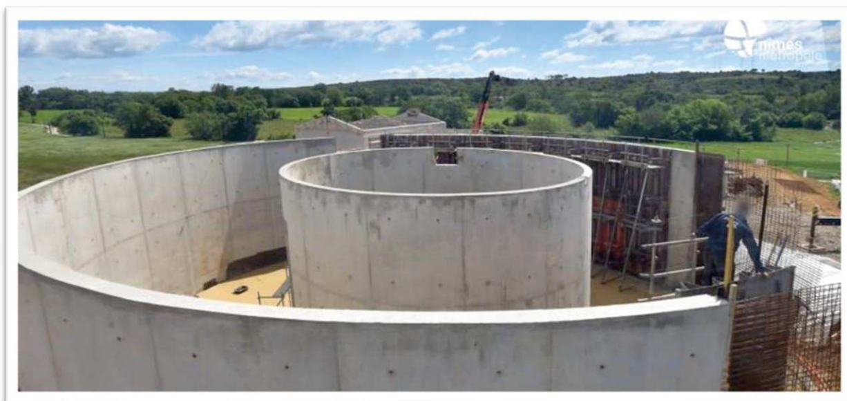
Bassin d'aération en construction (avec au centre zone anoxie)
