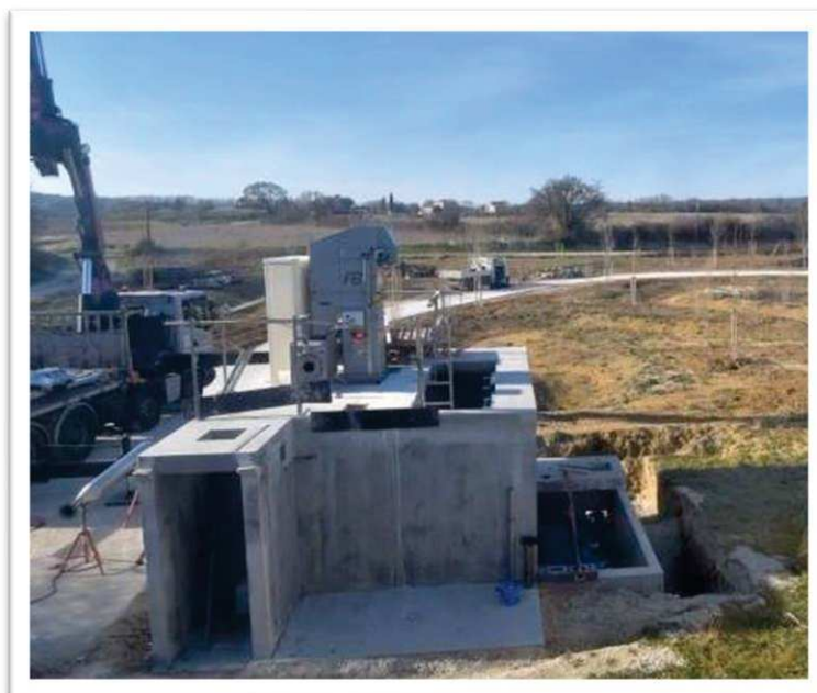
Poste de relèvement avec prétraitement au-dessus en construction
