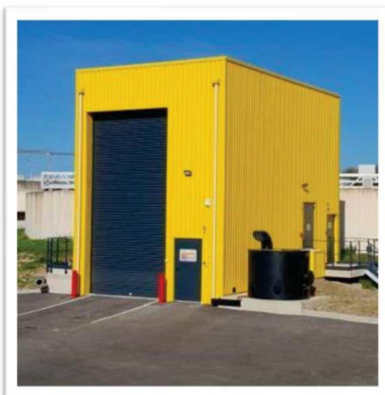
Unité d'accueil des boues externes – Steu de Nîmes
