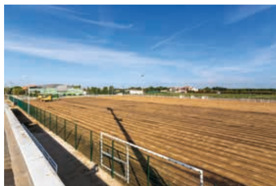
Réaménagement du stade Joseph Zanon
