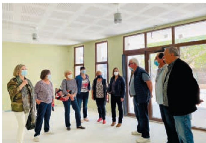
Les élus s'informant sur l'avancée des travaux de la crèche lors d'une visite de chantier, le 24 avril dernier.
